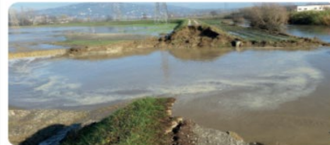
Moncalieri (TO) 2016: rotta d'argine
