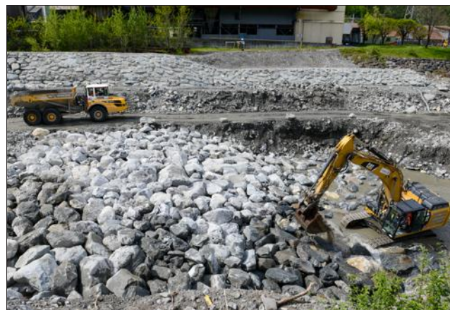
Le seuil du Claret, d'une hauteur de 3,5 m, est destiné à limiter l'érosion. Belle maîtrise des conducteurs pour manipuler ces blocs énormes !
